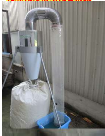
乾燥機に集塵機を新設
