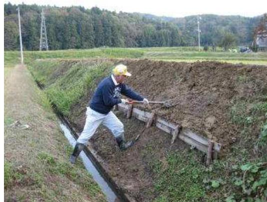
秋の台風等による長雨で畔に亀裂が入ったため、そのまま放置すると来春の崩雪解け水等で崩れおそれがあるため、直営作業で重機と人力により修理作業を行いました。
